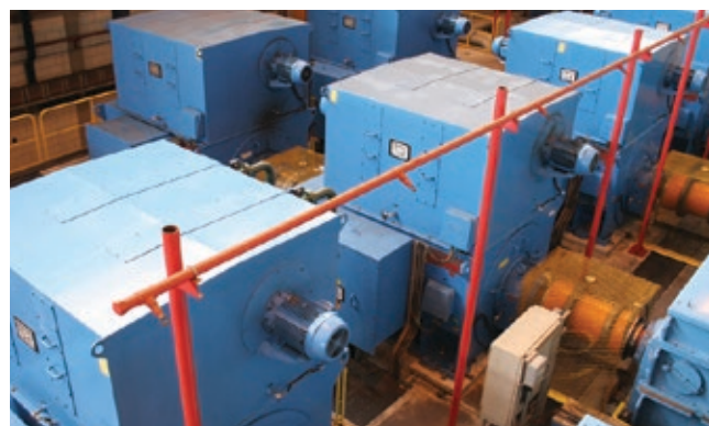
Motores Síncronos SDL800, 3.000 kW, 3.100 V Aplicação: Laminadores (siderurgia)
