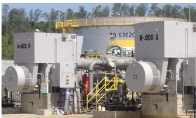
Motores Síncronos SEF900 (Ex-p), 3.600 kW, 13.200 V Aplicação: Compressores recíprocos (petroquímica)
